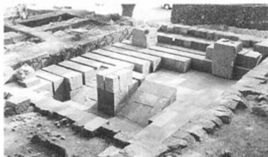
反射炉の基礎石組部分
