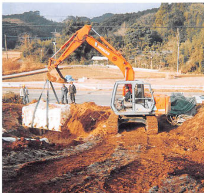
移設作業風景
