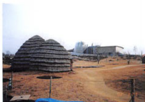
復元公開区から見た工事中の展示館
