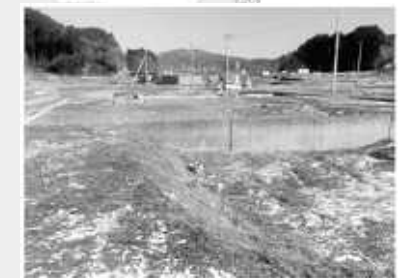
発掘調査現場周辺の津波被害の状況
