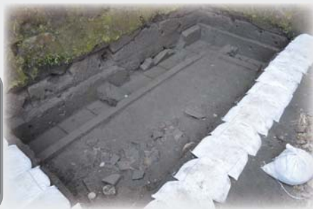
御楼門部分の排水溝
