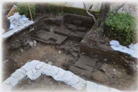
石垣の上の段の排水溝
