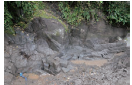
上流付近の導水路
