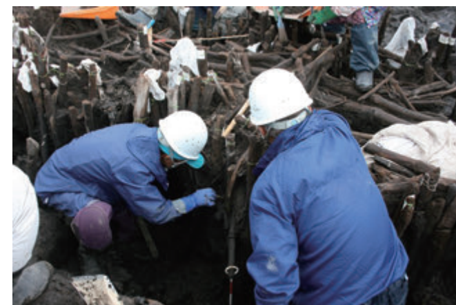
土木遺構 (杭列) の検出作業の様子
