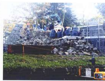
石道の解体修理の状況（宮城県仙台市史跡仙台城跡）
