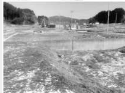
発掘調査現場周辺の津波被害の状況
