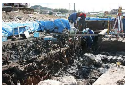
土木遺構（近世）の検出状況①
