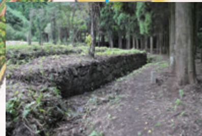
導水路カーブ部分
