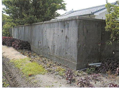
写真2 笠野原基地弾薬庫の被弾痕
