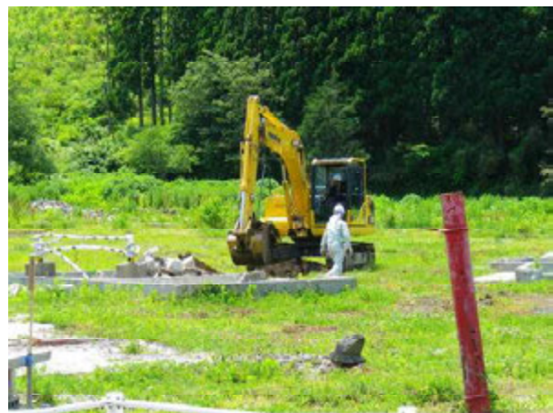
基礎だけ残った家屋の横を試掘するようす
