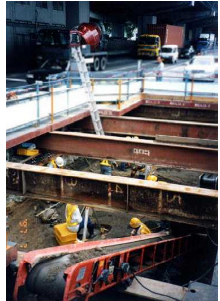
兵庫ノ津遺跡（神戸市） 排気ガスと騒音の中の鉄骨を組 んで国道2号線の地下を調べる。
