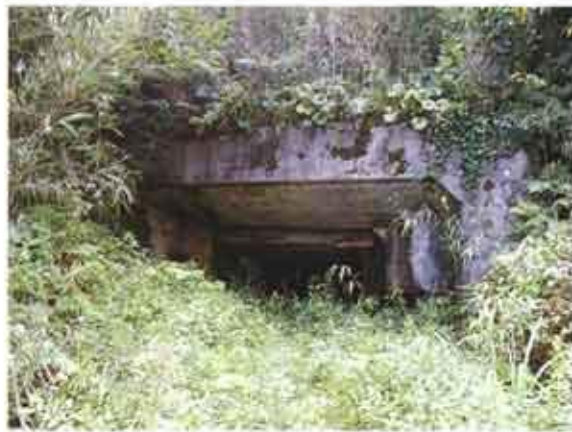
写真3 内之浦の本土決戦用砲台跡
