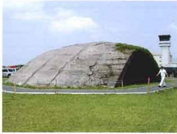
写真1 鹿屋基地内の有蓋掩体壕
