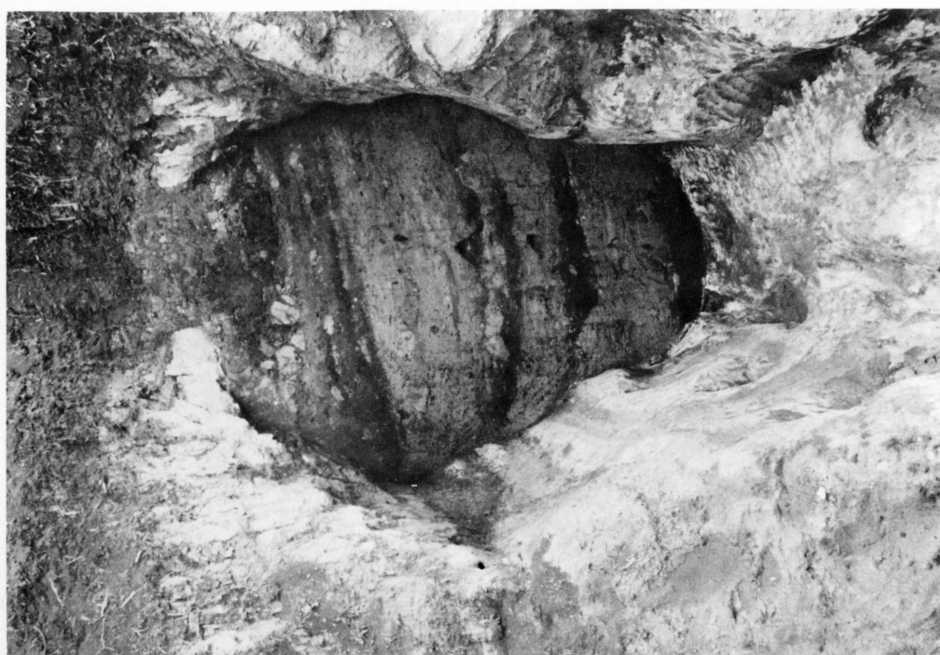
1. 隧道断面 (西から)
