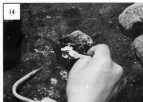
動く石はエポキシ系の接着剤で固定し、ひびがはいて土が動く場合は、エポキシ樹脂エマルジョンの原液を流し込んだり、土と練ったものをつめておく。 薬剤：エポキシ系接着剤、エポキシ樹脂エマルジョン
