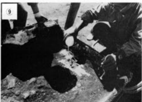
9 裏土の表面にエポキシ樹脂エマルジョンを塗って固める。 薬剤：エマルジョン（主剤・プリゾールL-601、硬化剤・プリゾールL-602）主剤対硬化剤＝3対1、適宜水でうすめる。
