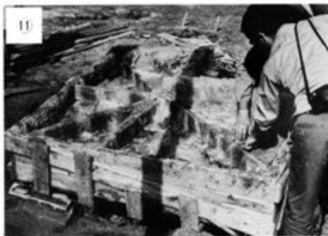
裏に支えの骨組をつくり、裏土と一体化させるため、ポリマールをしみ込ませたグラスファイバーマットをはりつける。
