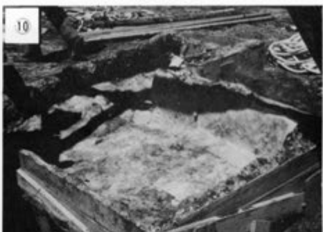
10 裏土の表面にポリマールをしみ込ませたグラスファイバーマットをはり、さらに固め、安定させる。 薬剤：ポリマール（ポリエステル樹脂）触媒にパーメック（ベンゾールパーオキサイド）を使う。主剤対触媒＝100対1
