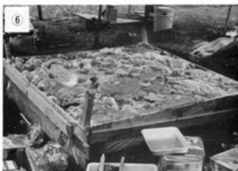
6 表面に発泡ウレタン樹脂を流し込み、さらに頑丈に固定する。発泡ウレタンの節約のため、ビニール袋等で風船をつくり、つめる。発泡が始まったら板等で圧力をかけ平らにする。 薬剤：ハイプロックス（主剤・硬化剤）主剤対硬化剤＝1対1
