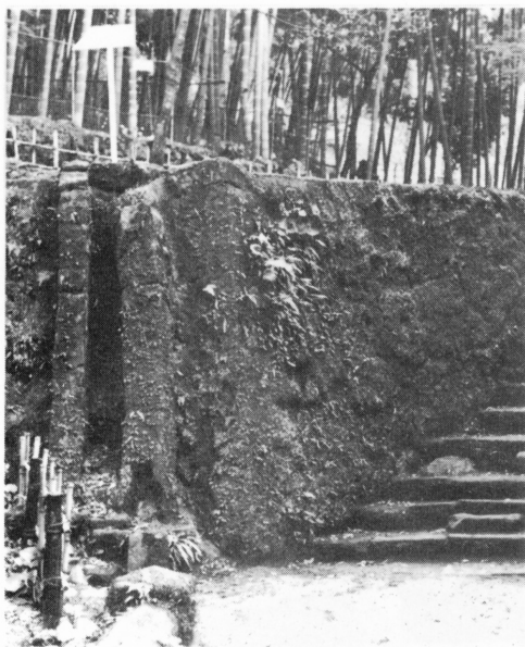
磯島津別邸上水道石管（現存）
