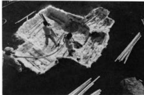
② 補強のため木材を入れて骨組みを作り、さらに、硬質発泡性ウレタン樹脂を吹付け作業を実施する。
