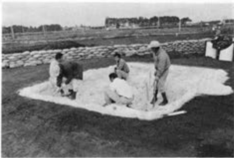
③ ウレタン樹脂の吹付け作業後数分割に切断作業を実施する。
