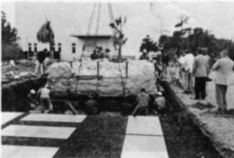
⑦ 据え付けにあたっては、運搬作業前に基礎工事を実施する。据え付にあたっては、実測図をもとに、レベル等を正確に合せて作業を進める。
