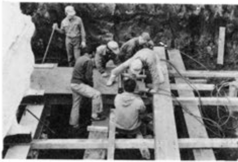
⑤ 硬質ウレタン樹脂の吹付け後、床面の切断のため鉄板挿入のために、堆進用ジャッキにより鉄板（12mm）を挿入し、切り離す作業を実施する。
