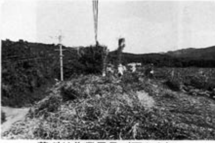
草刈り作業風景 (西から)
