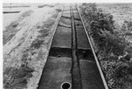
4. 中原山野遺跡のD区列全景 (東から)
