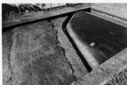
2. 碎石敷き部分と東側水路 (南から)
