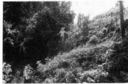
伐採作業風景（西から）
