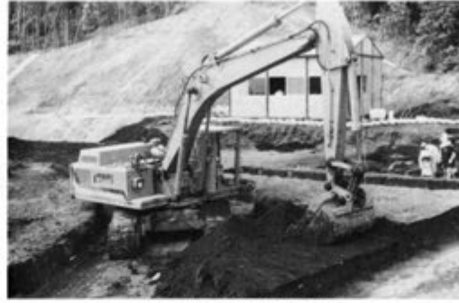
重機による表土剥ぎ
