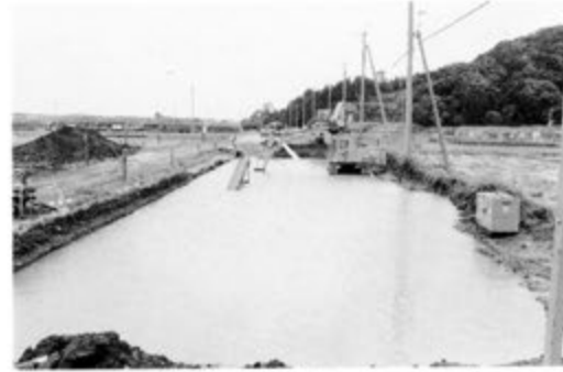
6. 遺跡地冠水状況 (A-1~5区)
