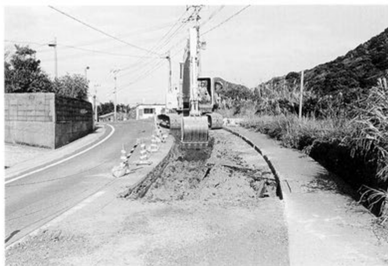
C地点舗装剥ぎ取り
