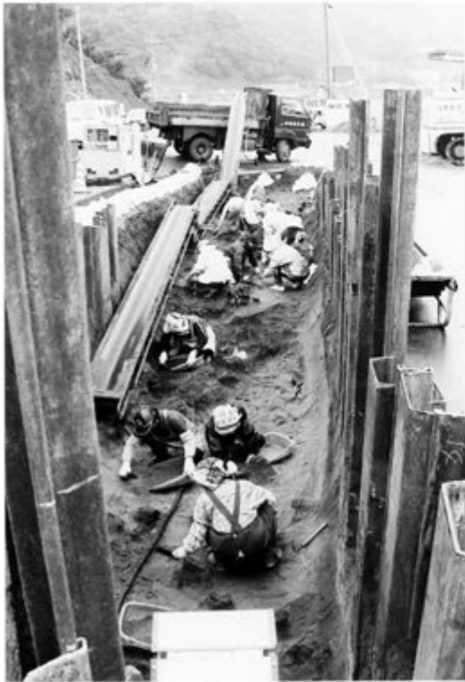
B地点 ベルコン・排土状況
