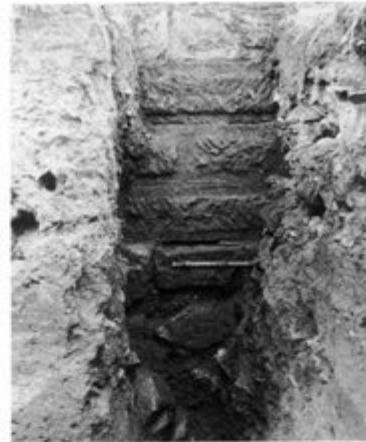
7 石塀積み重ね状況（裏側）
