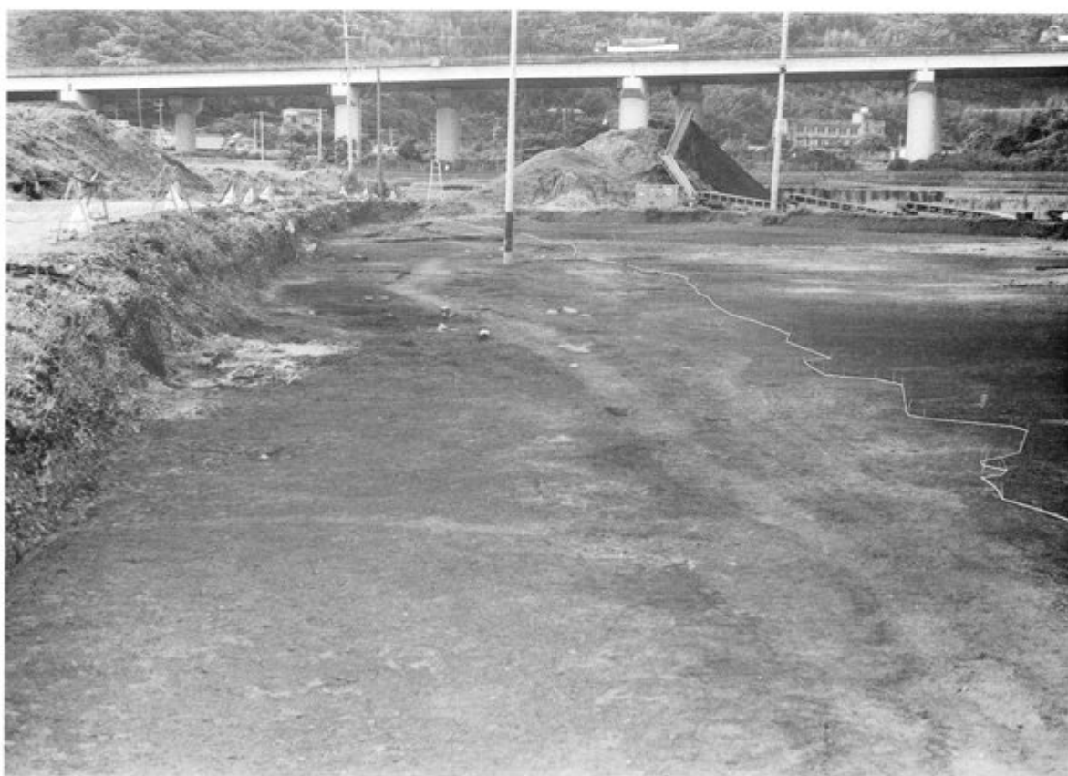
道路跡検出状況 1
