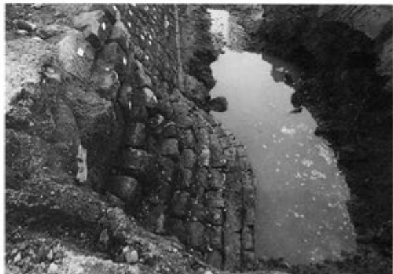
7. 船付場上流先端部
