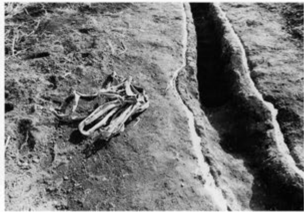
④ 配線溝と鉛管
