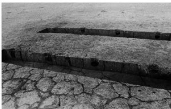
② 3号掘立柱建物跡柱穴断面
