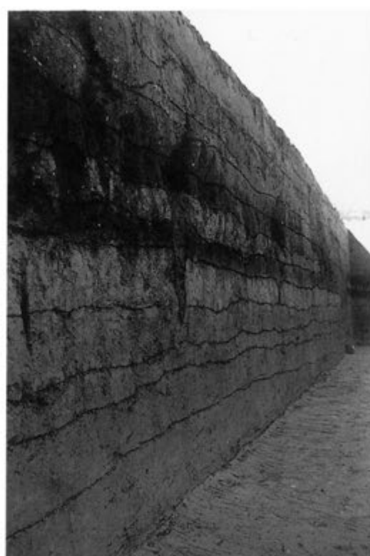
13トレンチ完掘状況（2）
