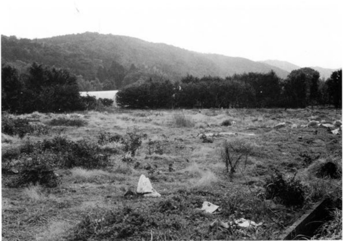
変電所建設部全景
