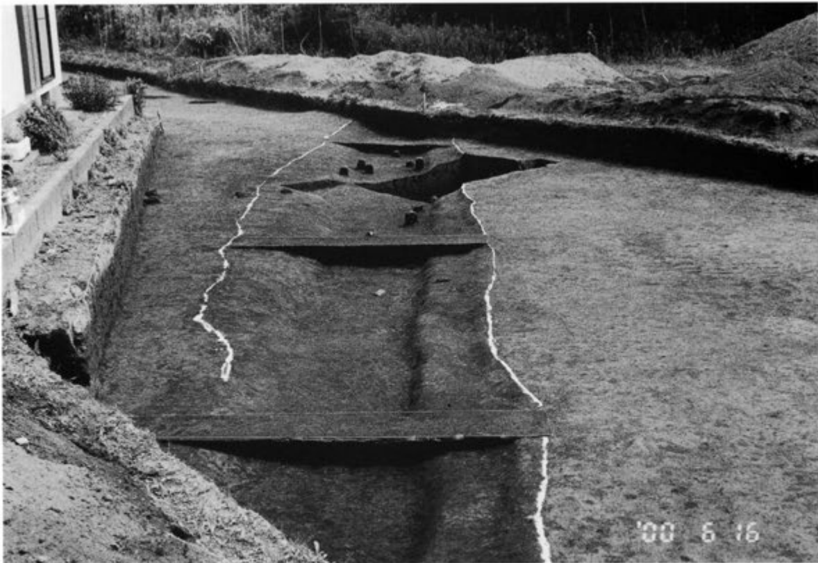
古道1調査状況
