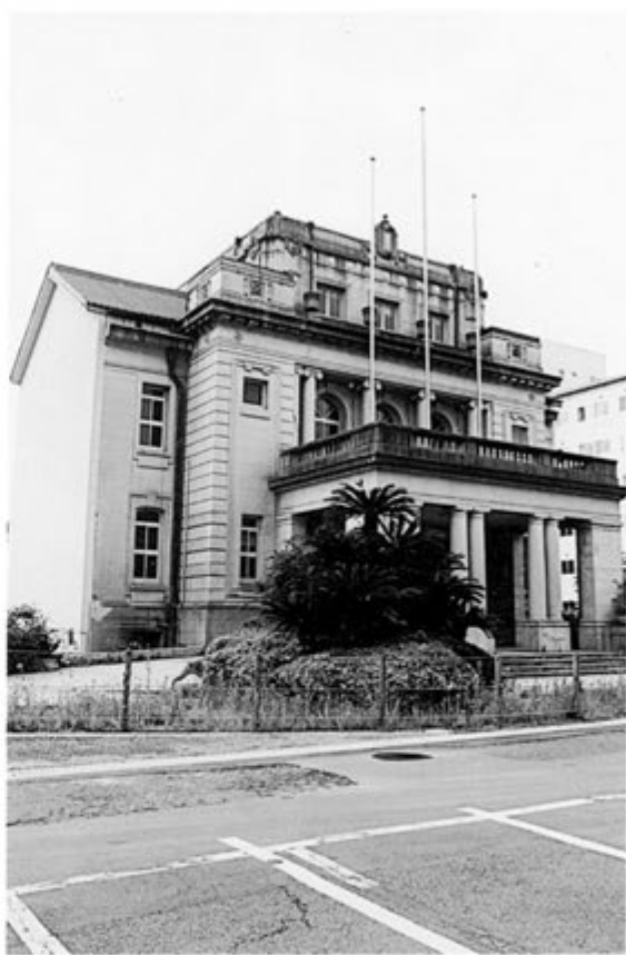
曳家工事前の旧鹿児島県庁舎本館
