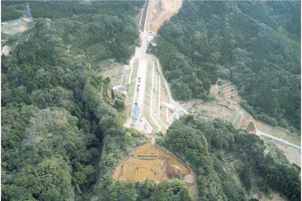
犬ヶ原遺跡遠景(西から)
