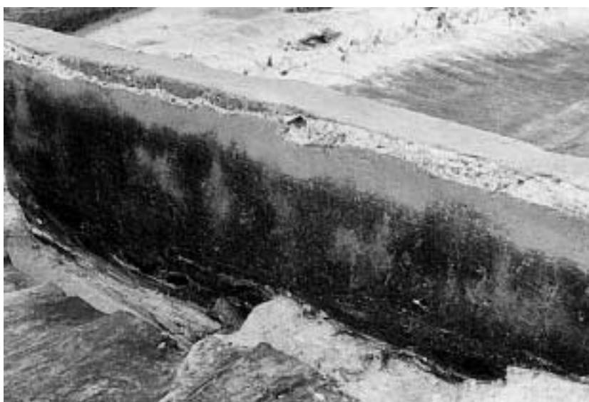
大型道路遺構 埋土断面
