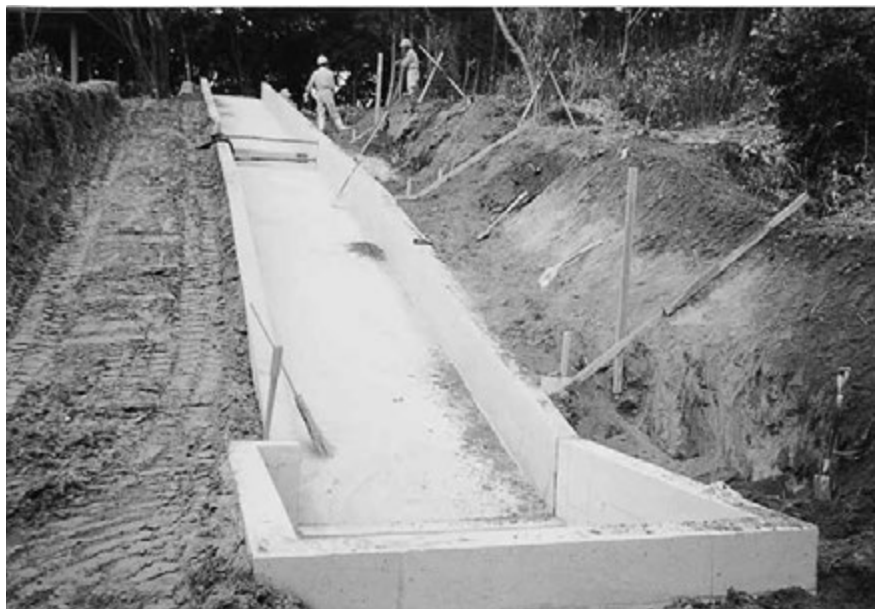
窯の据え付け枠
