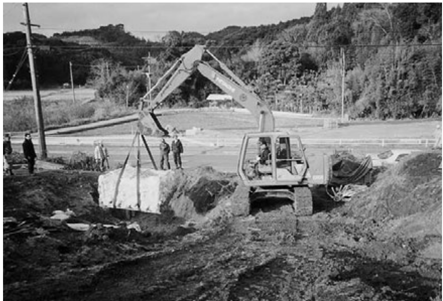
固定した遺構の 吊り上げ作業
