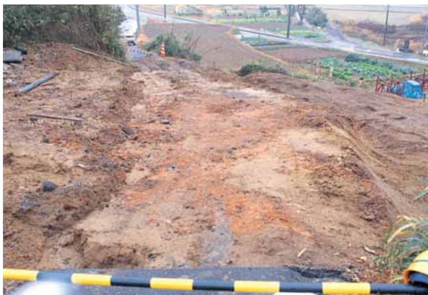
舗装剥ぎ取り後
