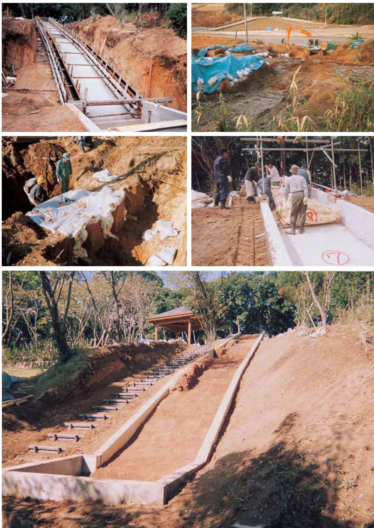
堂平窯跡移築状況
