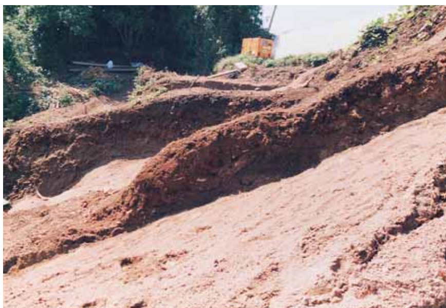
1 ~ 4D区物原 1 土層断面（中部）
