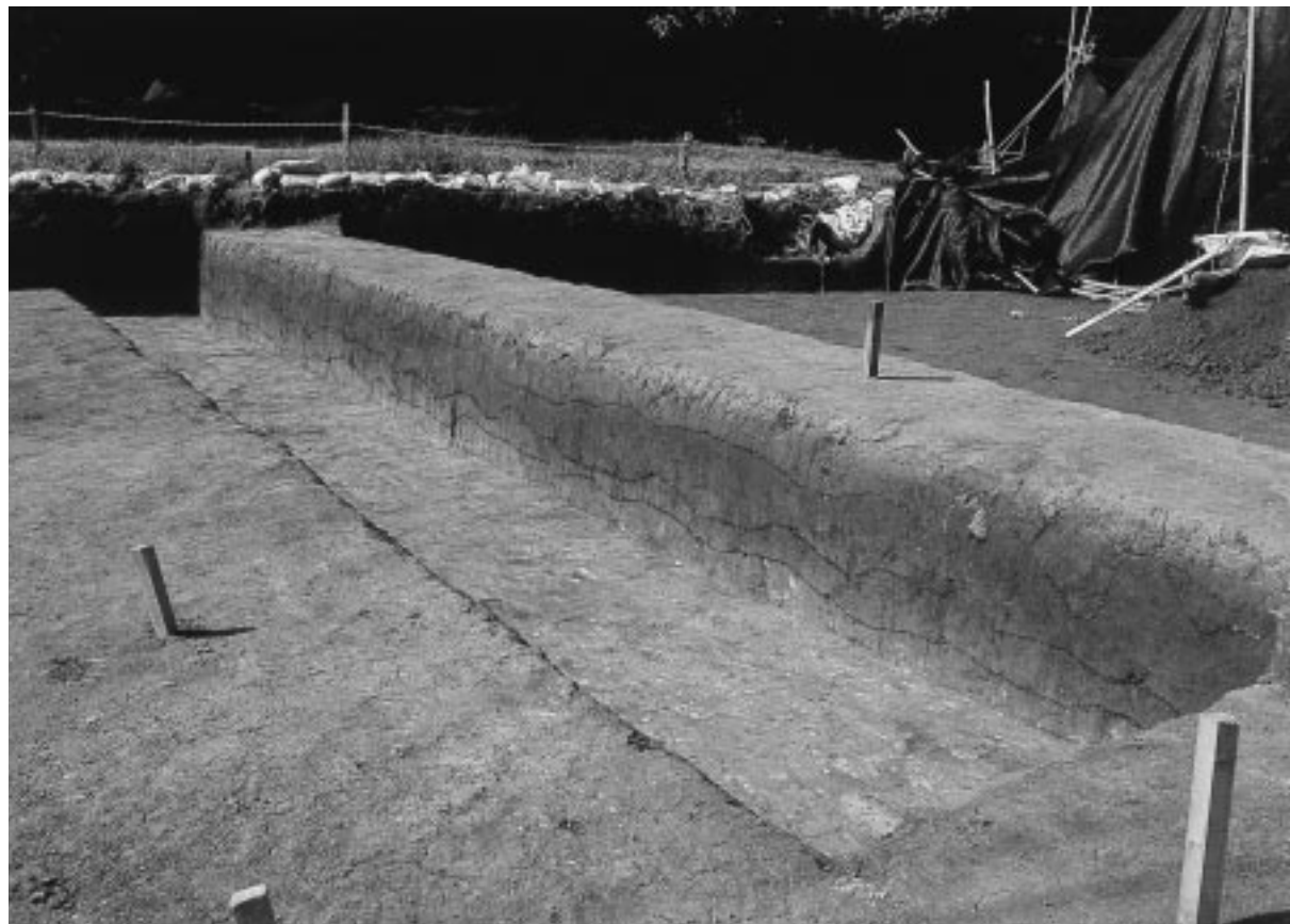
下層確認トレンチ設定状況
