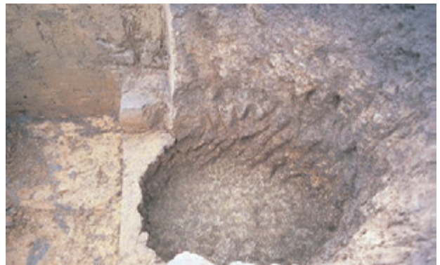
壁面に残る堀削痕
