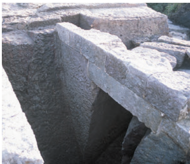
水車坑の排水口（岩盤を上から掘り抜いている）
