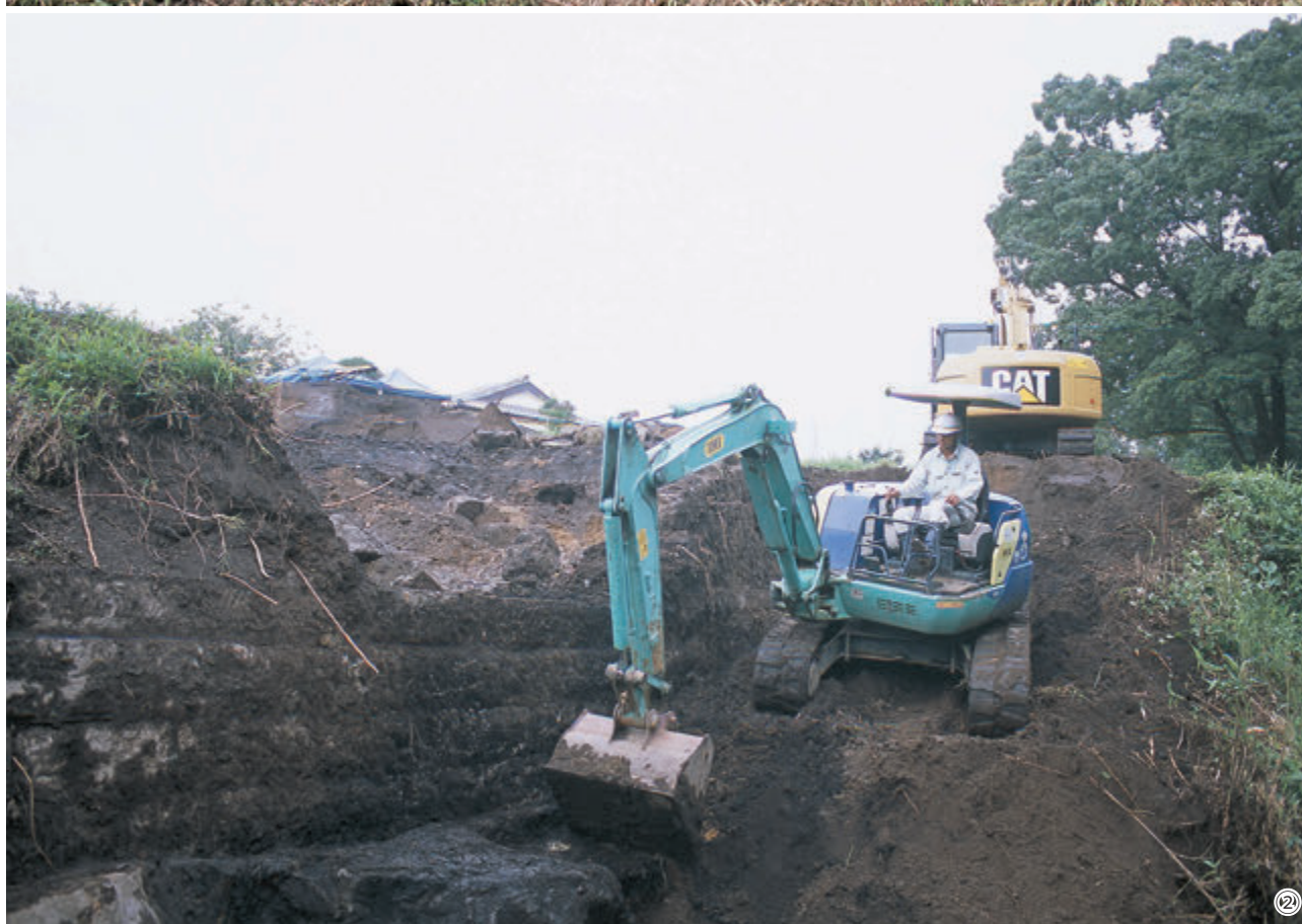
①表土に覆われる石垣 ②重機による表土除去作業 調査風景（１）
