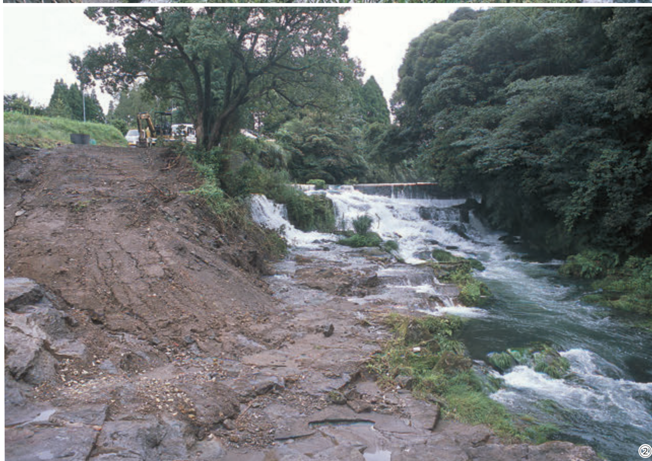
①麓川堰堤と導水溝への取水口 ②水車坑付近から堰堤を望む（麓川増水時） 現在の堰堤と取水口及び麓川
