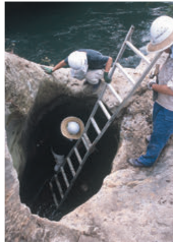
排水枡内の埋土掘り下げ状況
