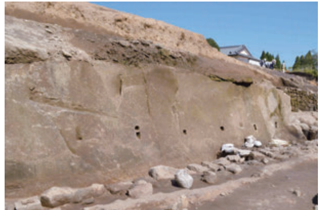
図9 阿多火砕流堆積物を整地した製錬所敷地跡
