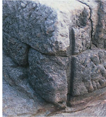
放水口の堰板溝，上部に四角い切り込み
