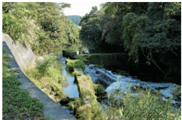
図11 麓川右岸の導水溝
