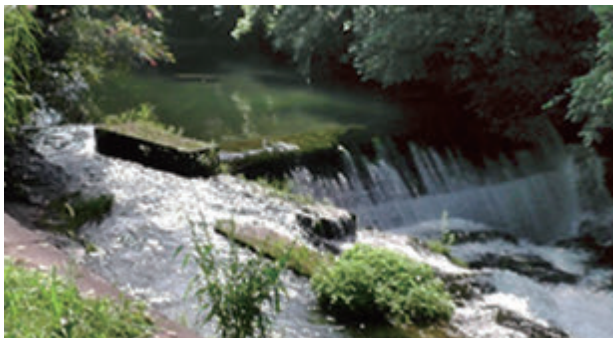
図5 取水堰と取水口
