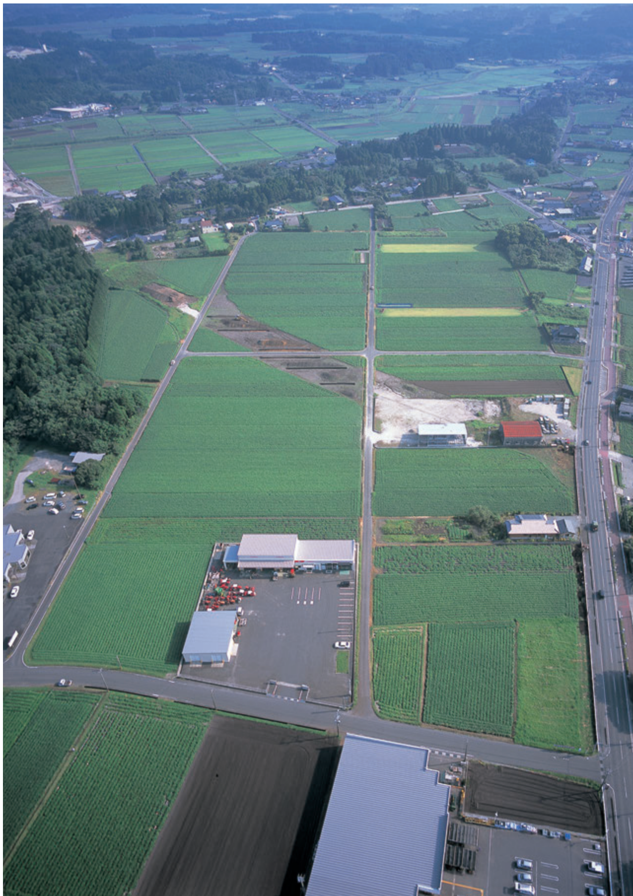
第2次拡張部 副滑走帯現況
