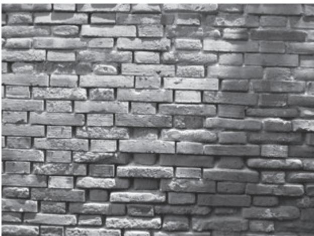
第109図 フランス積の煉瓦壁（小菅修船場引揚げ機小屋，
