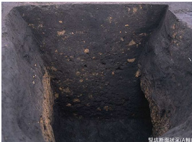
竪坑断面状況(A軸)
