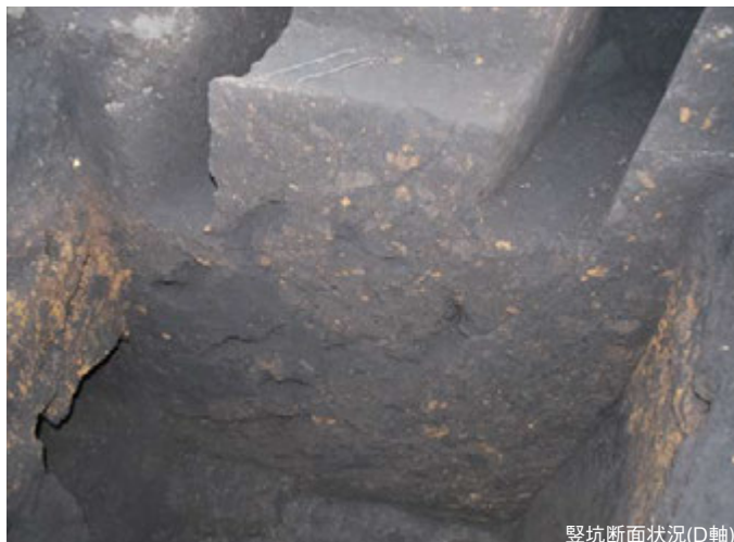
竪坑断面状況(D軸)
