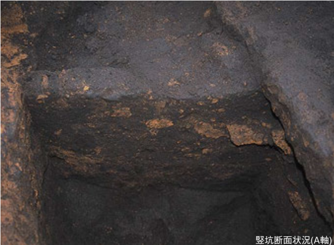
豎坑断面状況(A軸)
