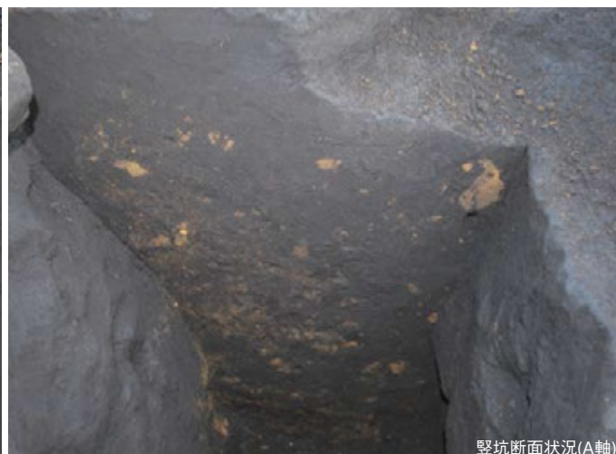
豎坑断面状況(A軸)
