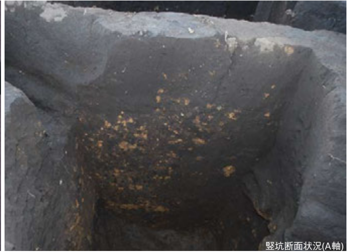
豎坑断面状況(A軸)
