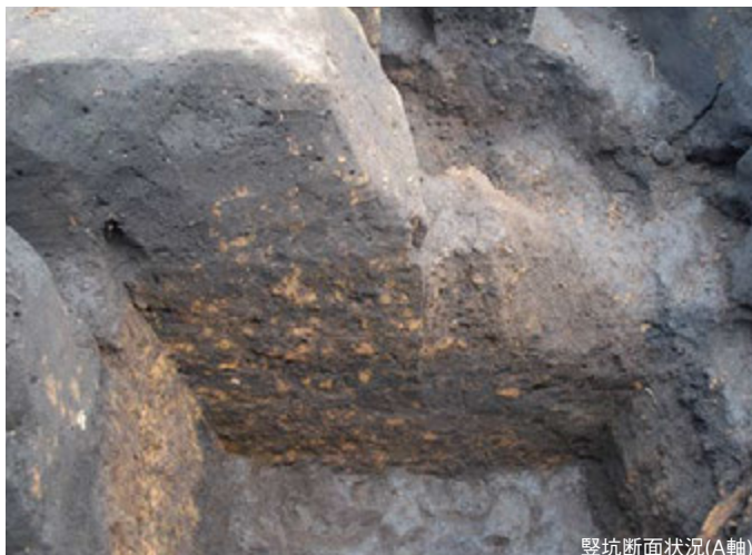
竪坑断面状況(A軸)
