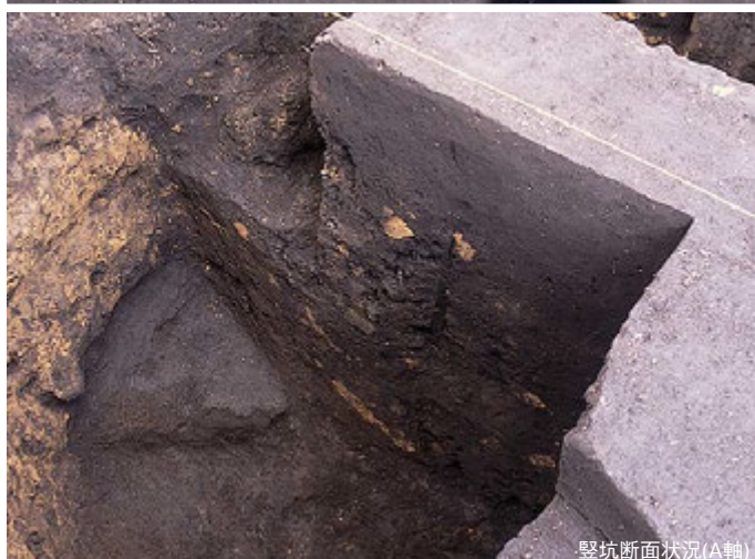
豎坑断面状況(A軸)
