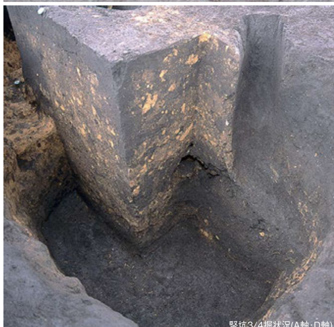
竪坑3/4掘状況(A軸・D軸)
