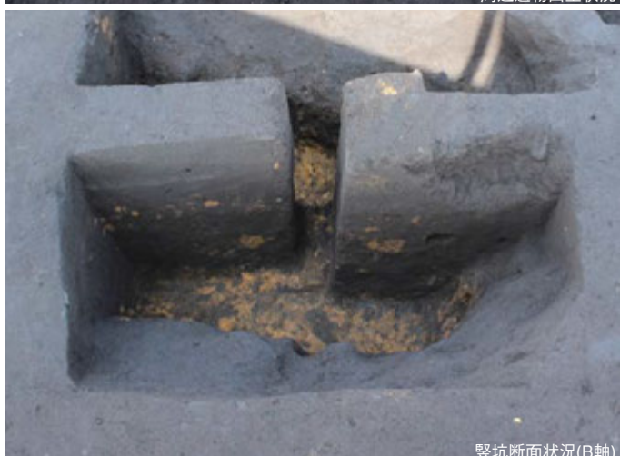
縦坑断面状況(B軸)
