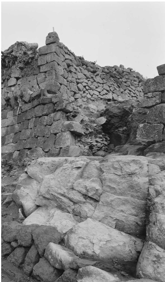
写真2 石切場跡に築かれた石垣
