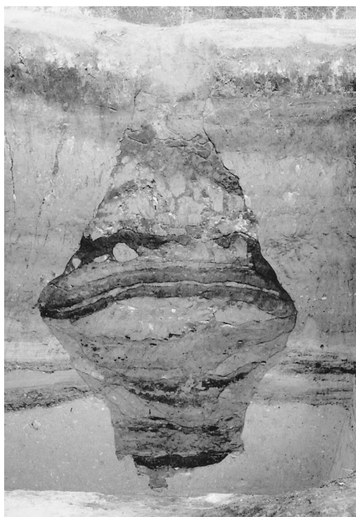
写真1 山城の隧道断面
