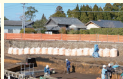
④大型土のう設置
