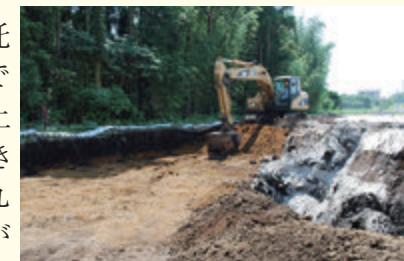
①重機による表土の掘り下げ
