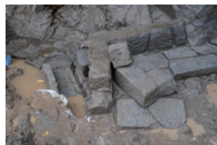
導水路の石積み・落水口
