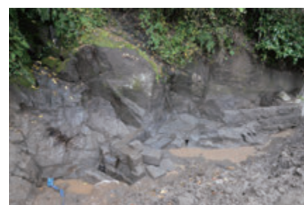
上流付近の導水路
