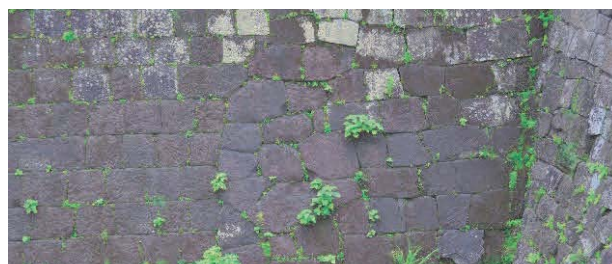
写真8 本丸北面石垣精加工間知石積みと布積み
