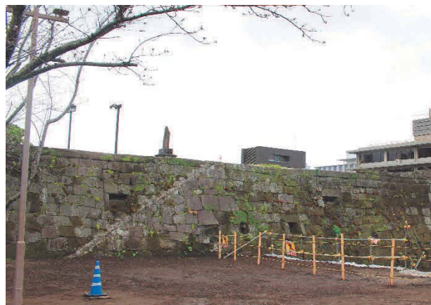
写真5 本丸南面石垣 (B面)
