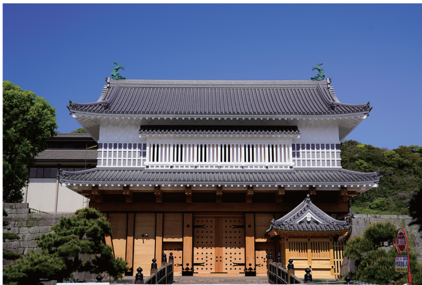
完成した御楼門（鶴丸城御楼門建設協議会提供）
