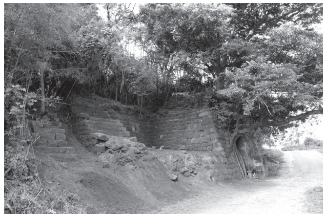
滝ノ上火薬製造所跡
