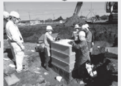
④ 上にはみ出たウレタンは切り取って、木枠にふたをする。
