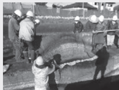
⑥ できあがり。その後持ち帰り仕上げを行う。
