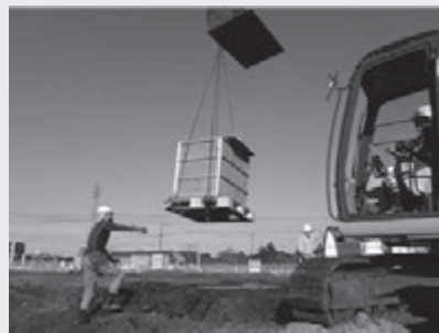
⑥ 切り取り完了。400kg 以上あったので重機で運搬しました。
