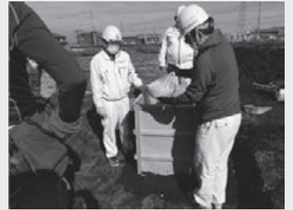
③ 作っておいた木枠を設置し、隙間に発泡ウレタンの液を流し込む。
