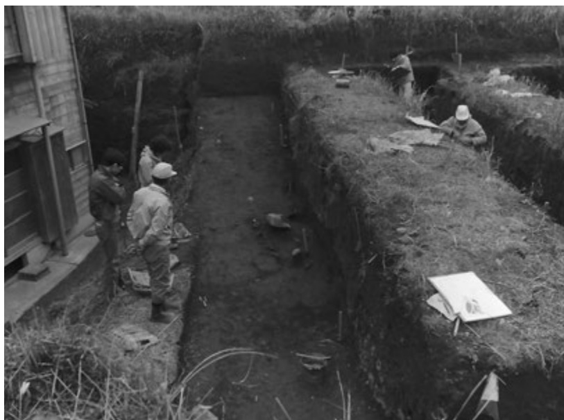
Mトレンチの調査状況（東側から）
